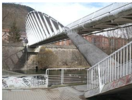
Pont de Calatrava, Ripoll
